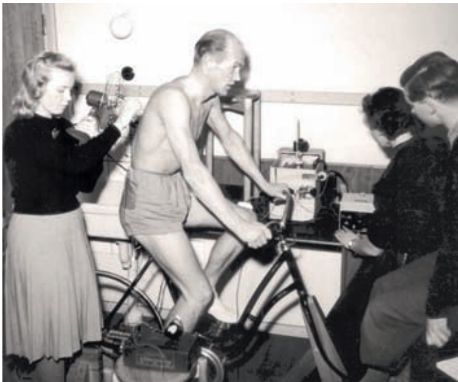
Ergometer-/test-/motionscykeln (kärt barn har många namn) utvecklades vid GIH. Här mäts muskel- och kroppstemperatur vid arbete.
