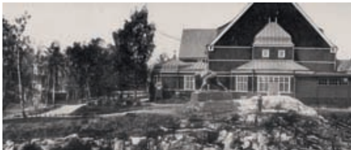
Stadionhöjden sedd från andra sidan Lidingövägen cirka 1910.
